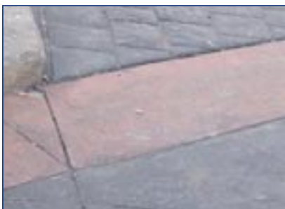
Fig.: 29. Pavimento de hormigón impreso
